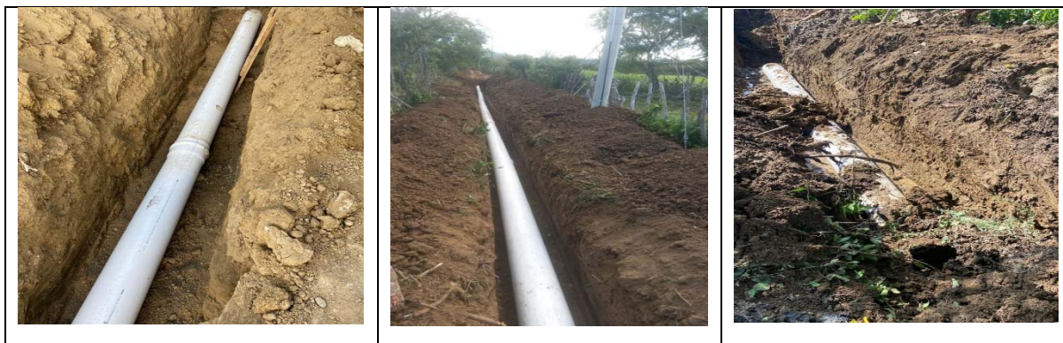
Suministro e instalación_Tubería PVC UM RDE 41 de 12" - Subestación No 12
