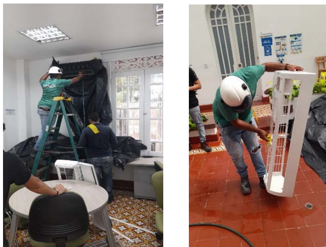
Mantenimiento aires acondicionados.
