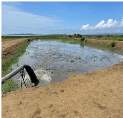
Descarga de sedimentos en piscina ubicada al lado del Arroyo Zapata.
